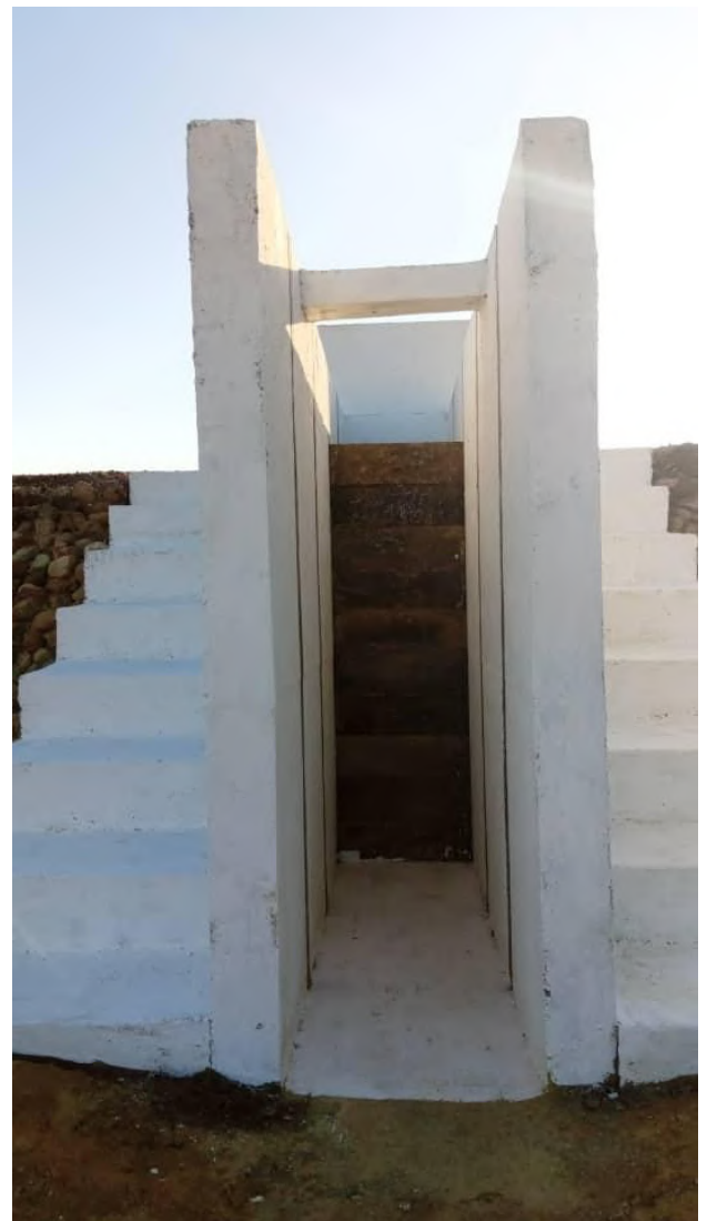
Compuerta de piscina reconstruida.
