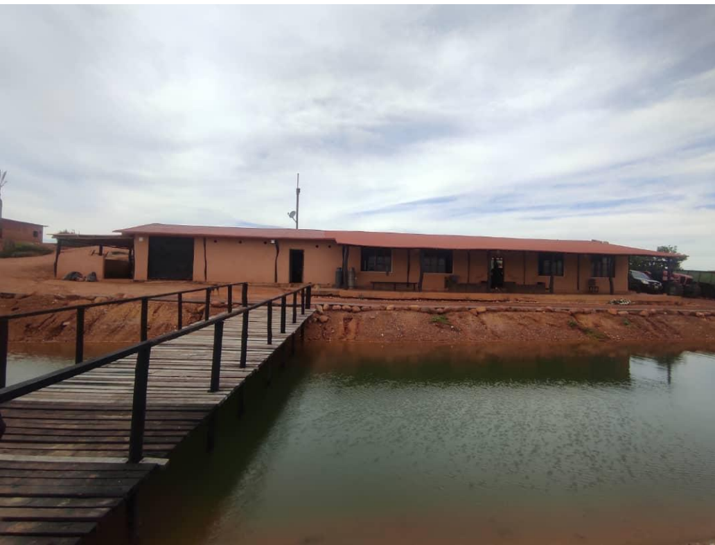
Campamento y puente renovados.
