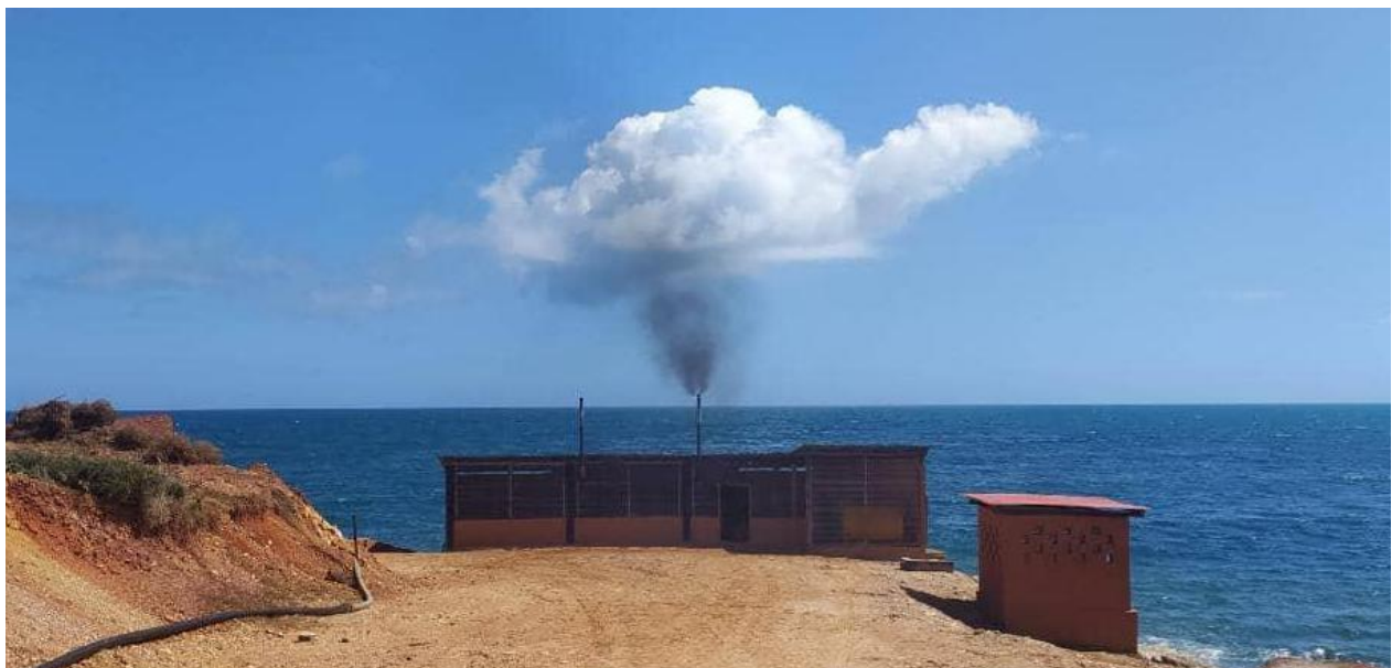
Estación de Bombeo. Nótese el emplazamiento y la calidad del agua.
