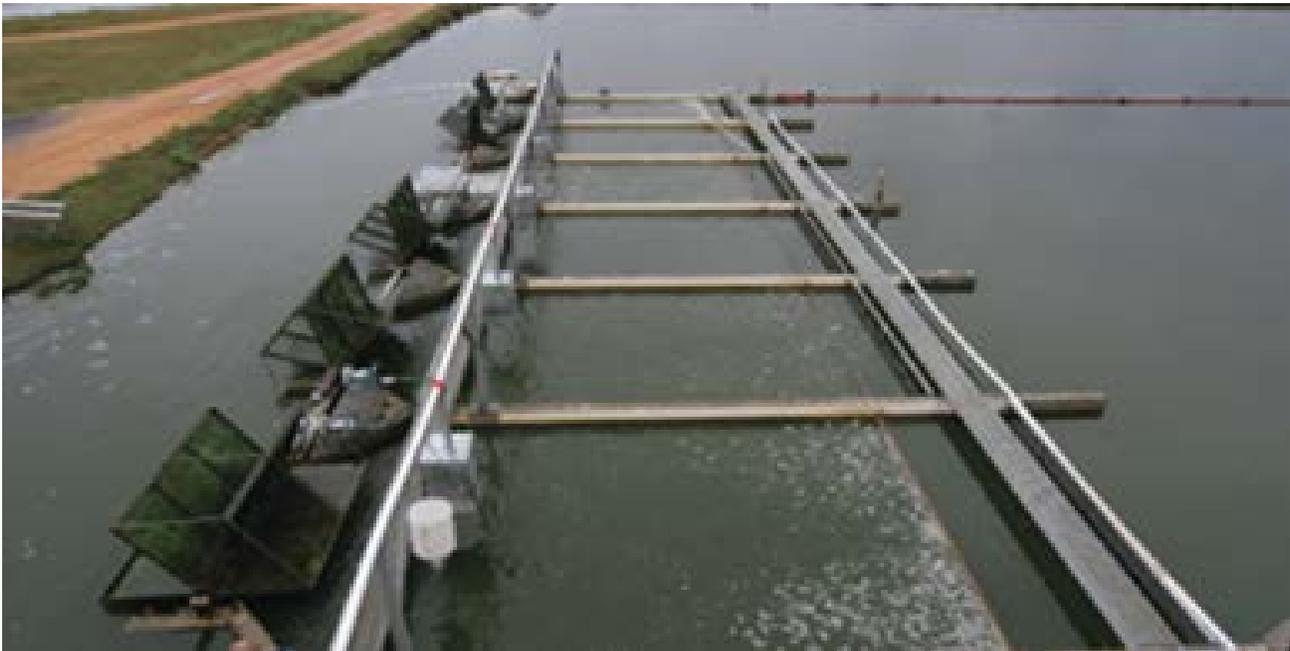
Figura 4. Imagen de uno de los primeros IPRS comerciales en Alabama en 2005, donde se utilizaban ruedas de paletas para mover el agua
