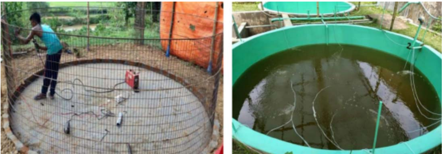
Fig. 3. Proceso de construcción del tanque BFT utilizando malla de alambre (A) y material de hormigón (B). Imagen cortesía del Sr. Debtanu Barman (CEO Aqua-Doctor Solutions Co. Ltd, India).
