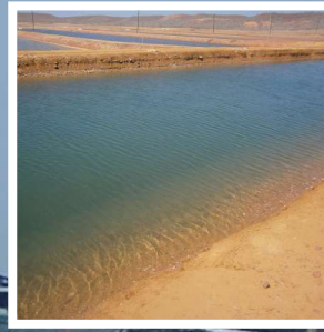
Canal de suministro de agua, Camaronera Promotora Los Cocos, Zulica, isla de Coche, estado Nueva Esparta, Venezuela.
