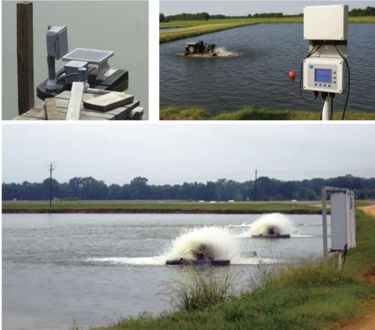
Figura 9. Sistemas de monitoreo de oxígeno en tiempo real en piscifactorías, junto con las cajas de control del aireador. Los aireadores se encienden automáticamente de acuerdo con la concentración de oxígeno medida en el momento en cada estanque.
