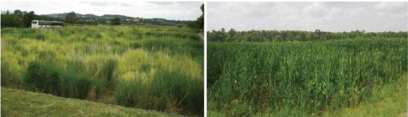
Figura 2. Tanques con vegetación y humedales utilizados en el tratamiento de aguas residuales.
